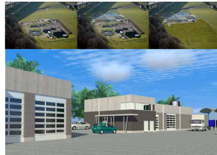
Au dessus : Avant, pendant et après travaux. Ci-contre : Nouvelle station d'épuration - bâtiments
